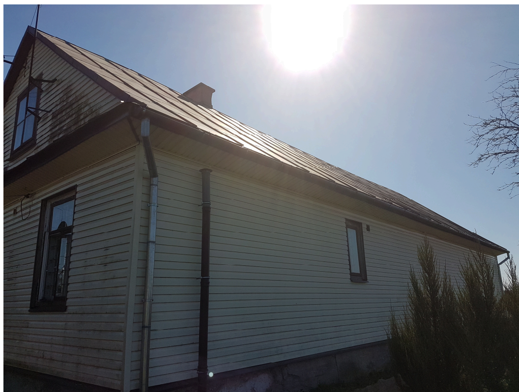
Zdjęcie Nr 2 – elewacja budynku
