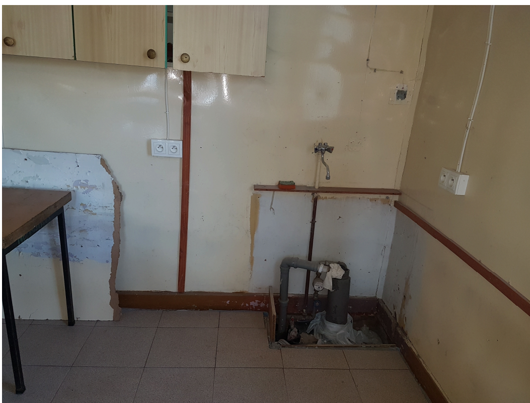
Zdjęcie Nr 6 – ściany sala nr 2
