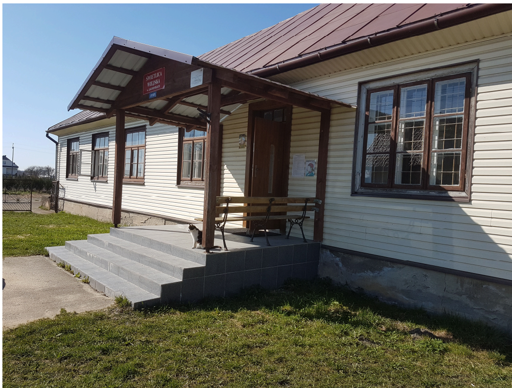
Zdjęcie Nr 1 – elewacja budynku
