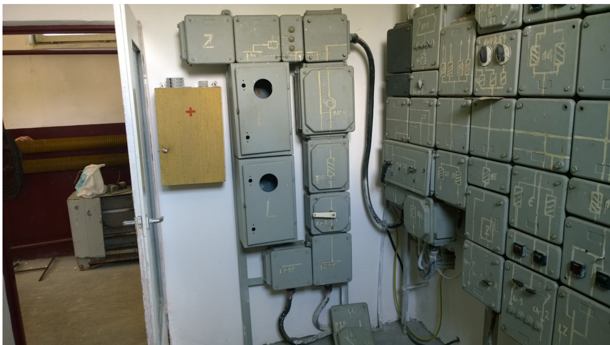
Widok agregatu prądotwórczego i układu SZR:
