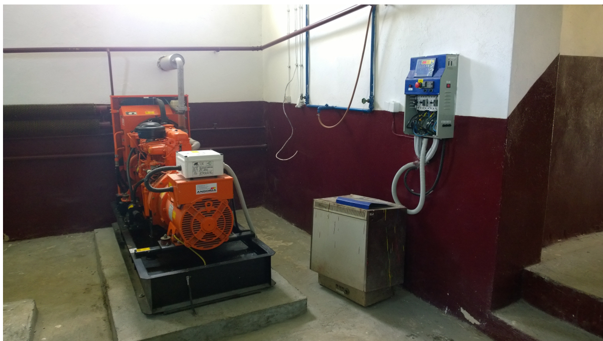
Widok agregatu prądotwórczego i układu SZR:
